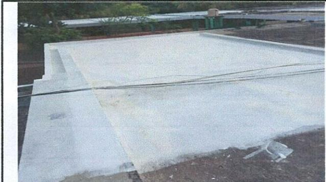
Foto 3: IMPERMEABILIZACION DE LOSA
